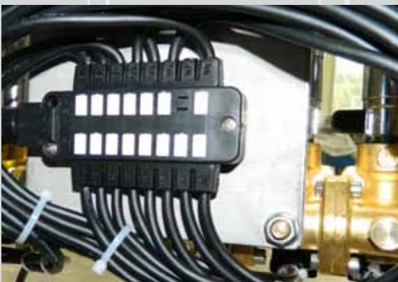
La connessione delle elettrovalvole al quadro elettrico risulta particolarmente semplificata ed identificabile grazie ad un cablaggio dedicato multiconnessione.
